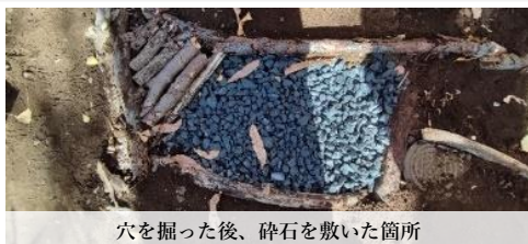
穴を掘った後、砕石を敷いた箇所
